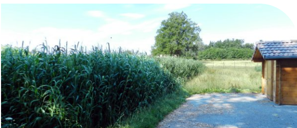
Filtre planté de roseaux à Garnerans - Système naturel de traitement des eaux usées domestiques dont le curage est à prévoir en moyenne tous les 10 à 15 ans en fonction du taux d'accumulation des boues.
